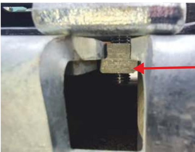
Die Verschraubung sollte immer mit Federscheibe und Unterlegscheibe auf dem U-Stück der Klemmplatte befestigt werden.
